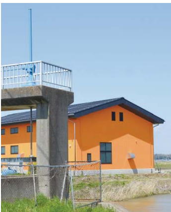
余郷入干拓の排水機場
